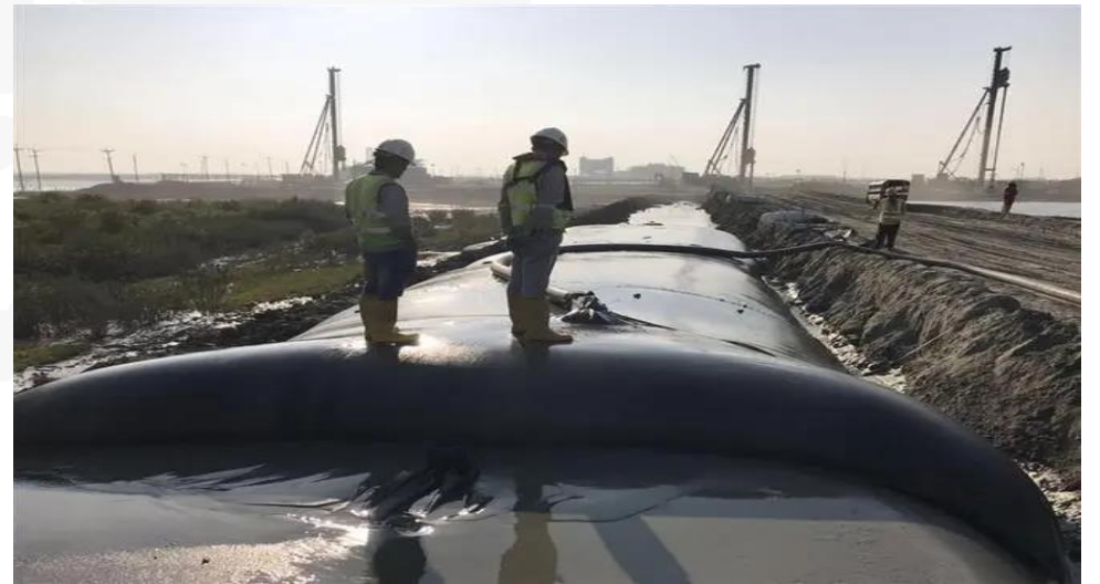
土工管袋固化法示意图
