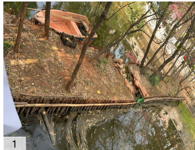
1、7池现状无法自然连通，依靠水泵抽排
